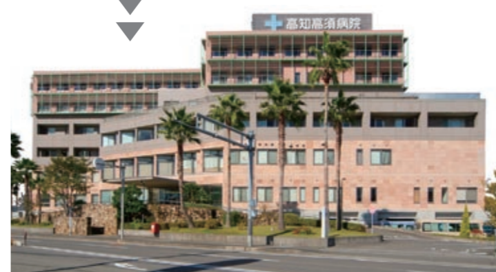
増改築工事後の高知高須病院
