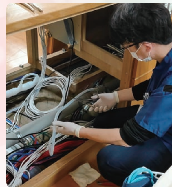
古い配管を取り外す様子
