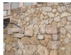
◀ピカピカになった石壁
